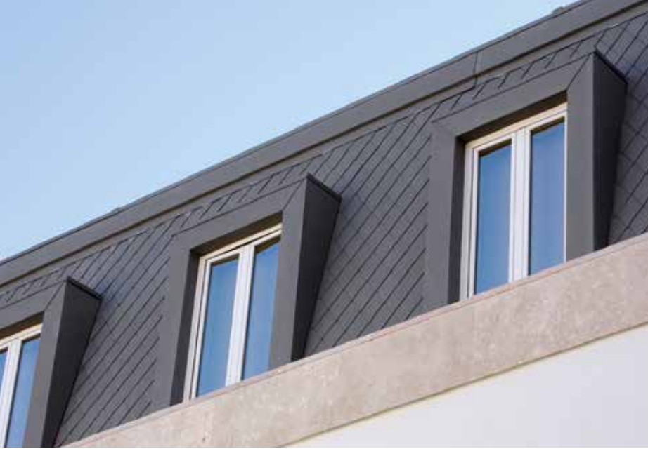
Kentsel Dönüşüm Pul Cephe Uygulaması
